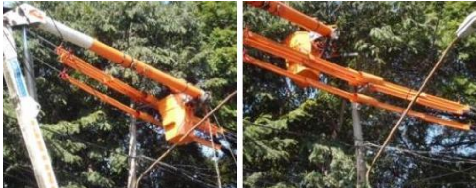
Figura 39 – Isolação de trecho de Rede Aérea (mínimo de protetores isolantes)
