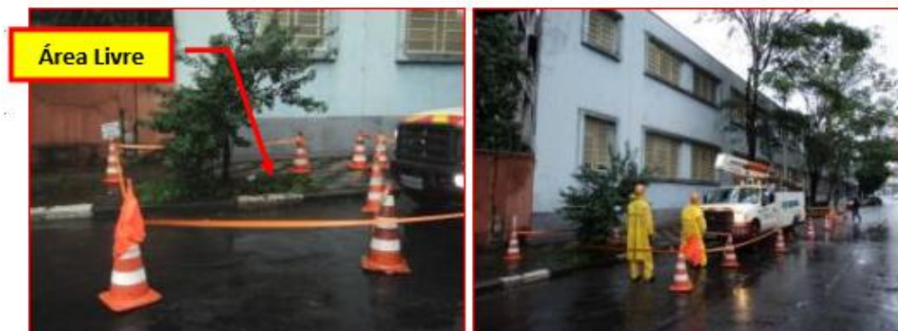
Figura 37 - Sinalização de canteiro e/ou área de trabalho
