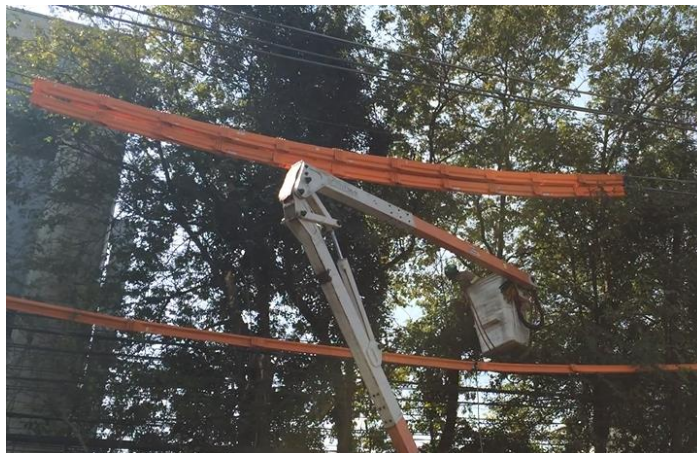
Figura 42 - Isolação do Trecho de Rede Aérea
