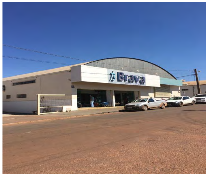
Figura 6 - Fachada Revenda (foto própria)
